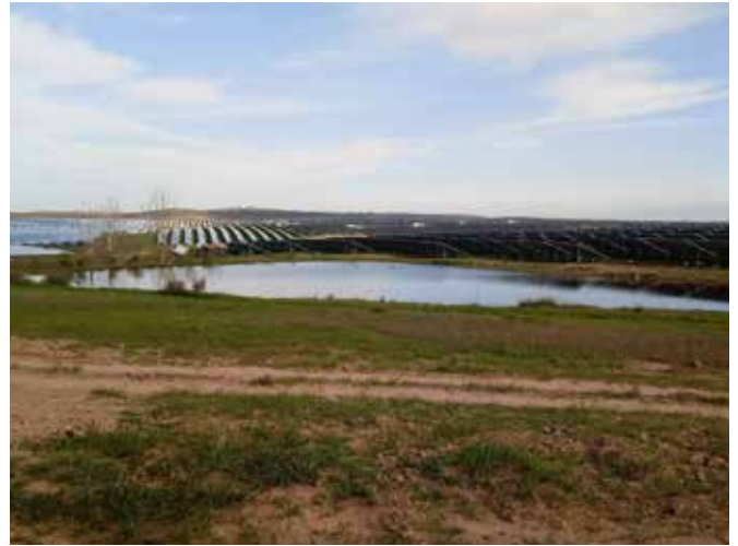
Charca en el interior de la planta
