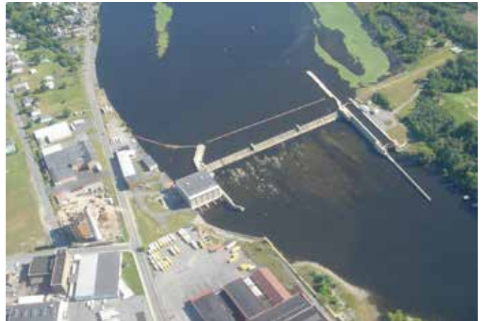
Planta hidroeléctrica de Upper Mechanicville de NYSEG
