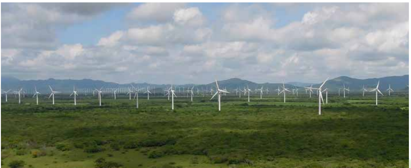
Parque eólico de La Venta III
