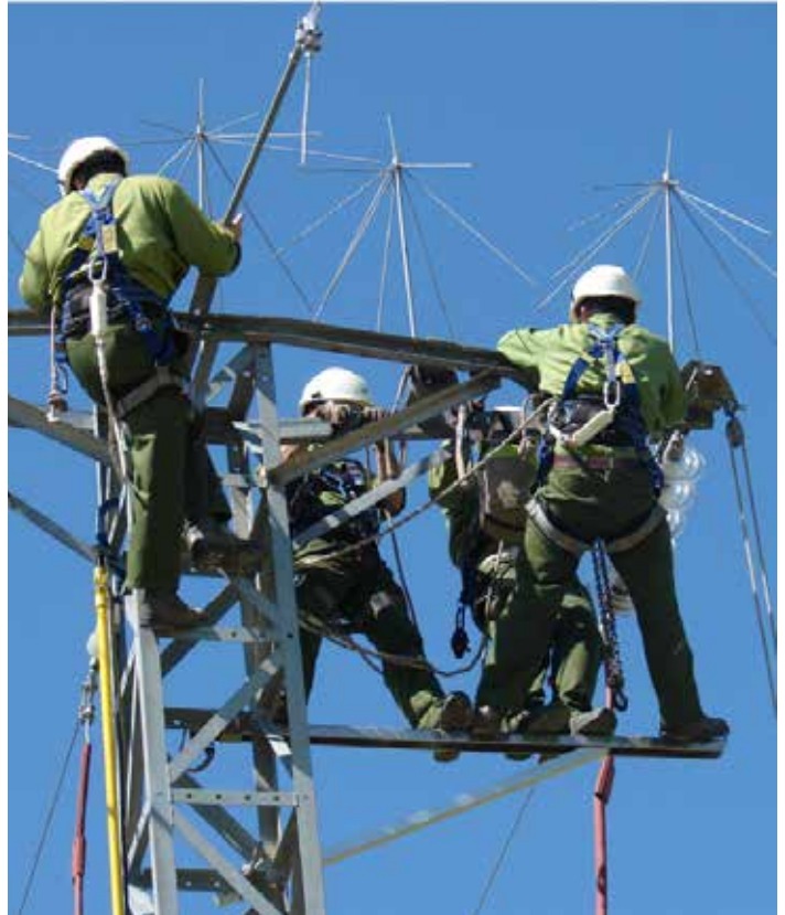
Protección avifauna - Aleteo
