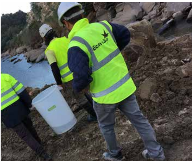
Equipo de técnicos ambientales en una labor de seguimiento de obra
