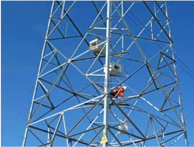
Instalación de cajas nido en apoyo 18
