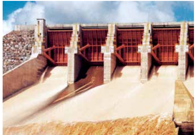
Central hidroeléctrica de Itapebi
