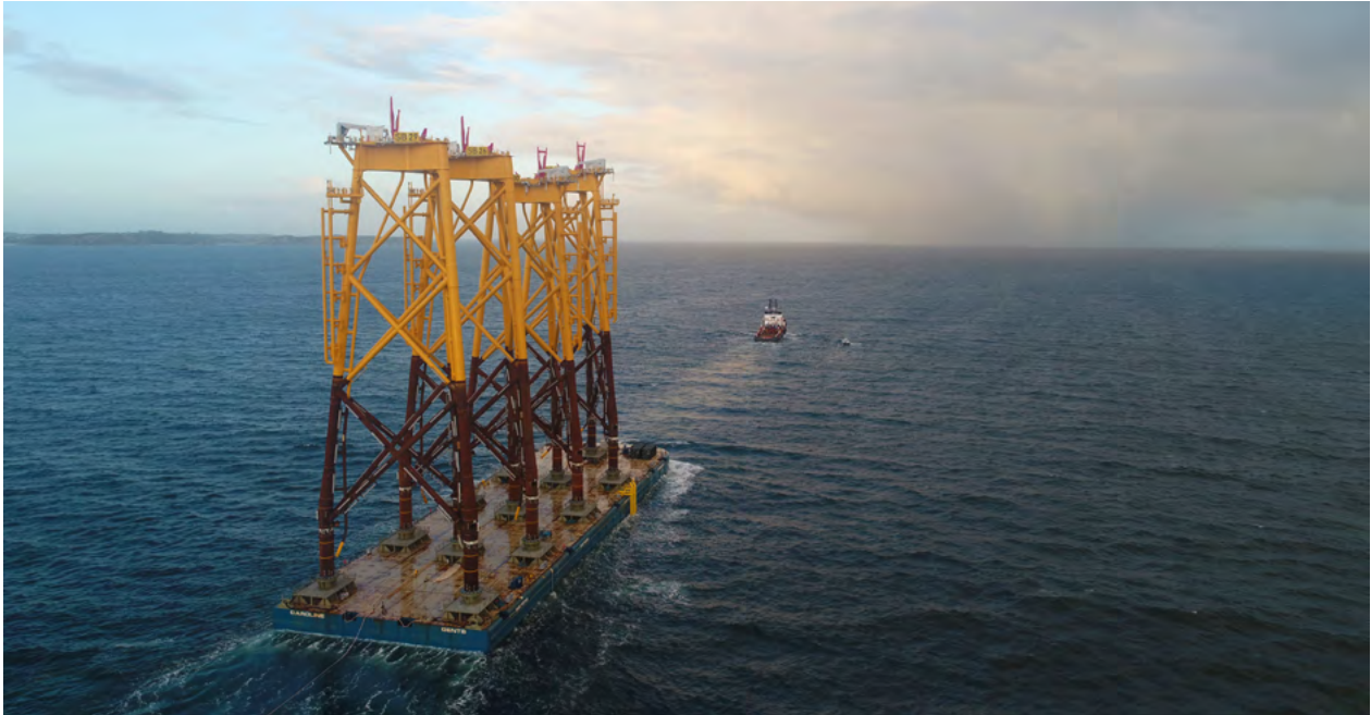
Construcción del parque eólico marino de Saint Brieuc, Francia
