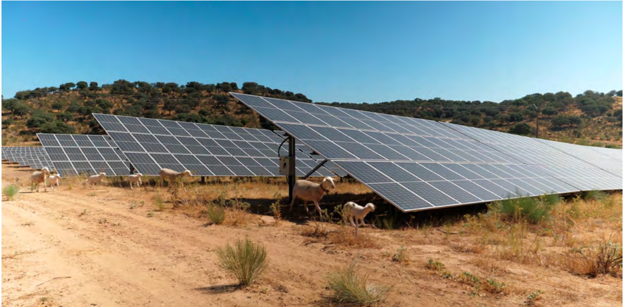
Planta solar de Arañuelo, Cáceres, España
