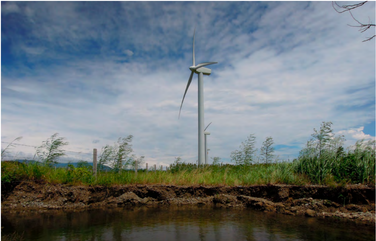
Parque eólico La Venta III, Santo Domingo Ingenia, Oaxaca, México
