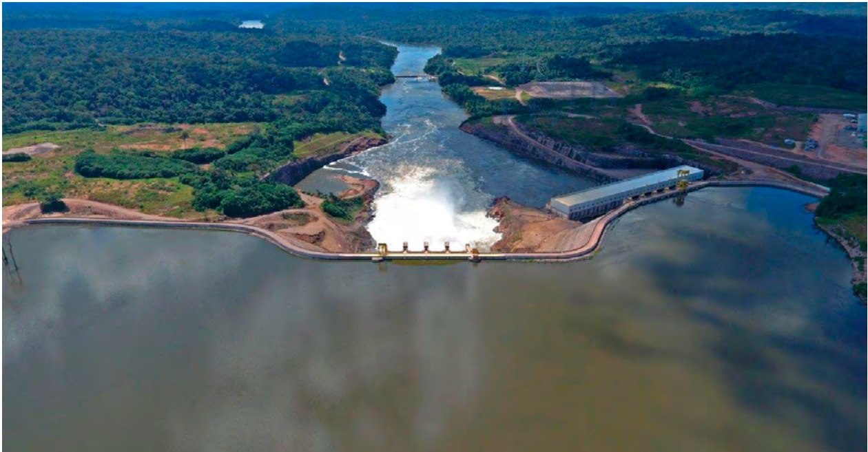
Central hidroeléctrica de Teles Pires, Pará y Mato Grosso, Brasil
