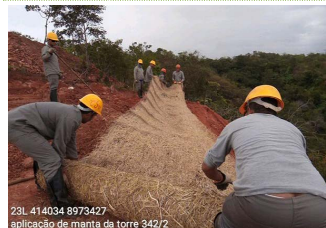
Aplicación de manta de sisal como medida de contención - Torre 342/2 Canteiro Monte Alegre do Piauí - 19/04/2021
