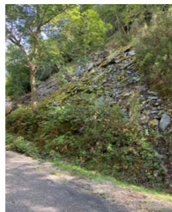
El Águila demolición sifón
