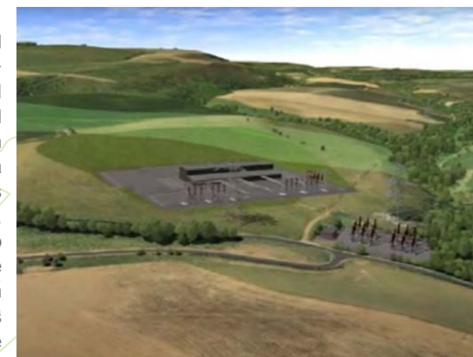
Foto ilustrativa de la subestación propuesta en Branxton.
