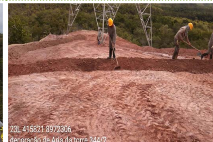
Instalación de dispositivos de drenaje como medida de contención de la erosión - Torre 344/2 Canteiro Monte Alegre do Piauí - 22/04/2021
