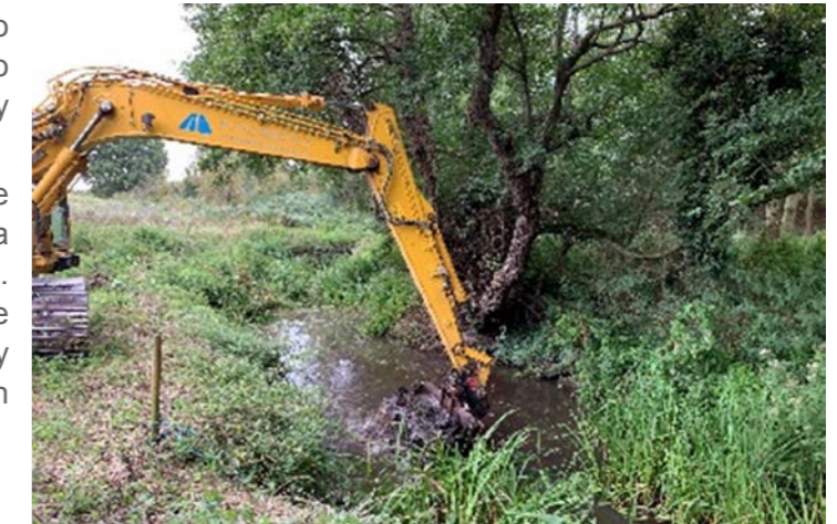
Retirada de arena para mejorar el cauce del río Fynn.
