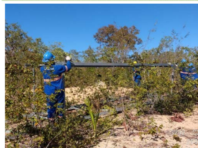
Atividade de desmantelamento de estruturas metálicas - Torre 259 16/09/2020
